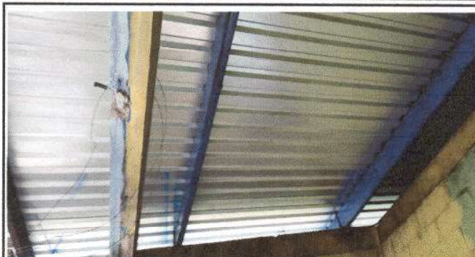
Foto 2: MÓDULO 1 AULAS: Mantenimiento a estructura de soporte de metal.
