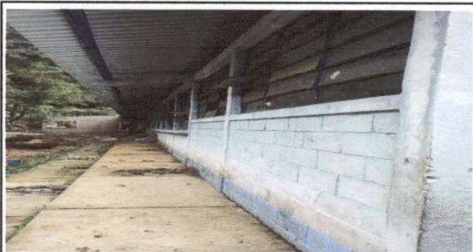
Foto 3: MÓDULO 1 AULAS: PINTURA EN MUROS EXTERIORES E INTERIORES: Pintura en muros exteriores e interiores
