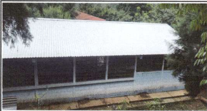
Foto 1: MÓDULO 1 AULAS: CUBIERTA DE LÁMINA: Sustitución de lámina, por lámina troquelada aluzinc calibre 26, Sustitución de capote de lámina para lámina troquelada
